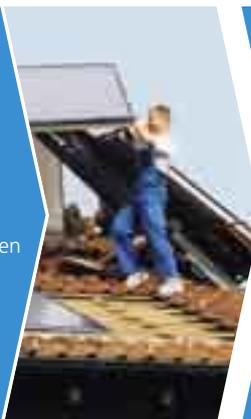
Der Kollektor wird auf's Dach gehoben und vorsichtig aufgesetzt
